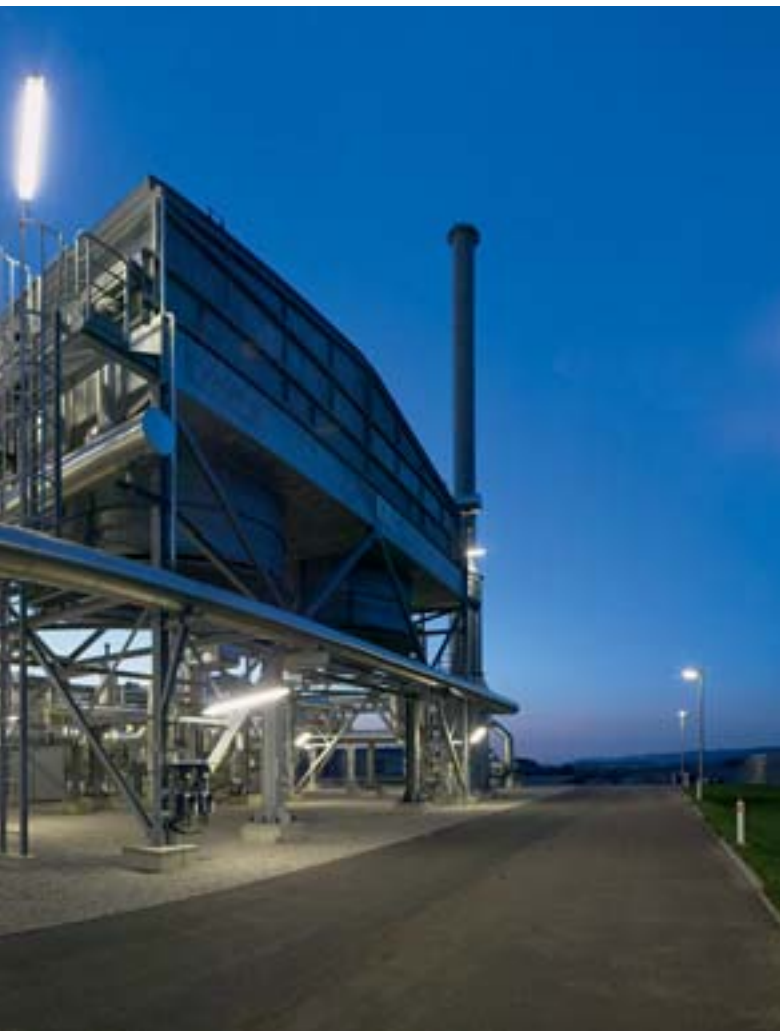
AUWENDIGE TECHNIK IST NOTWENDIG, UM DAS GAS IN DEN SPEICHER IN 1600 METER TIEFE ZU PRESSEN.
