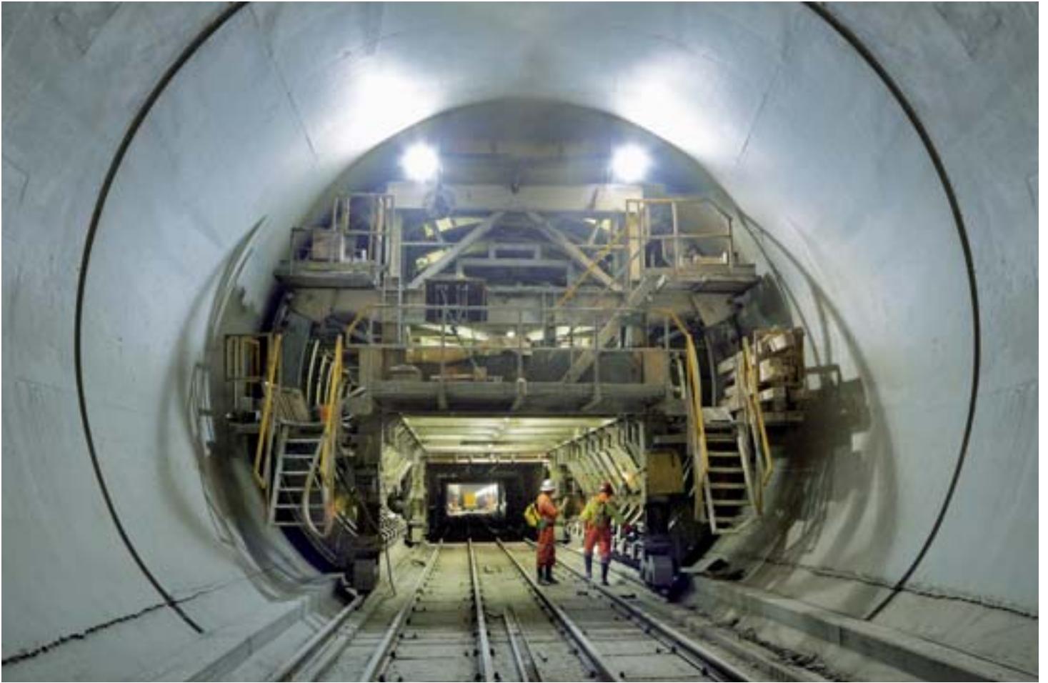
MIT HILFE RIESIGER SCHALWAGEN BETONIEREN DIE TUNNELBAUER DIE RÖHREN AUS.
