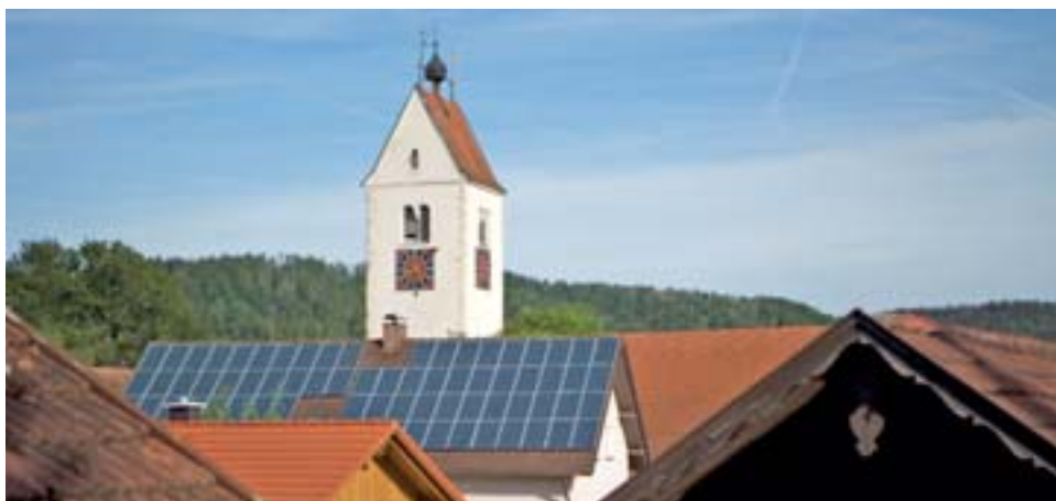
SOLARZELLEN AUF DEN DÄCHERN BRINGEN DEM DORF 70 000 EURO PRO JAHR. NUR DIE DENKMALGESCHÜTZTE KIRCHE TROTZT DEM TREND.
