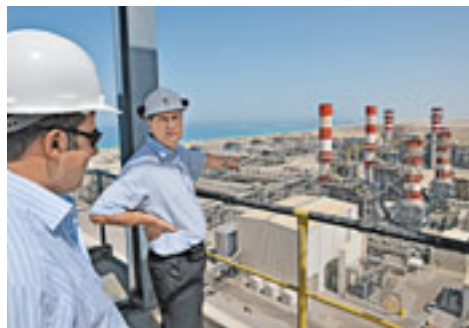
VATER RIEDEL IST WARTUNGS-CHEF DES KOMBIKRAFTWERKS AL TAWEELAH B
