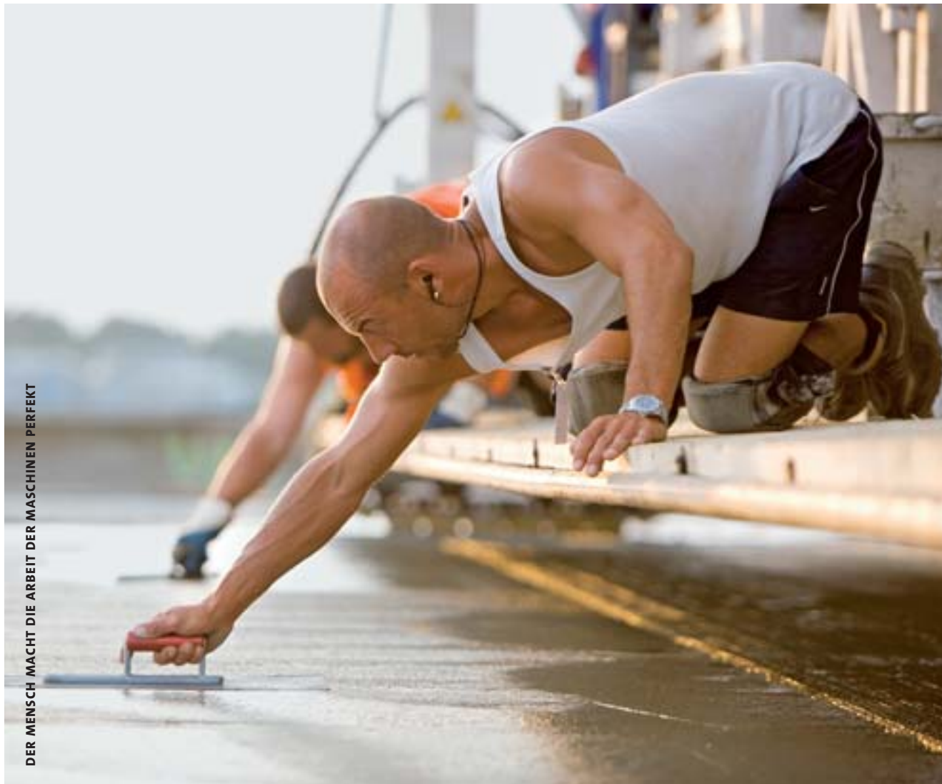
DER BESENSTRICH SORGT FÜR RIEFEN UND DEN GRIP DER FLUGZEUGREIFEN
