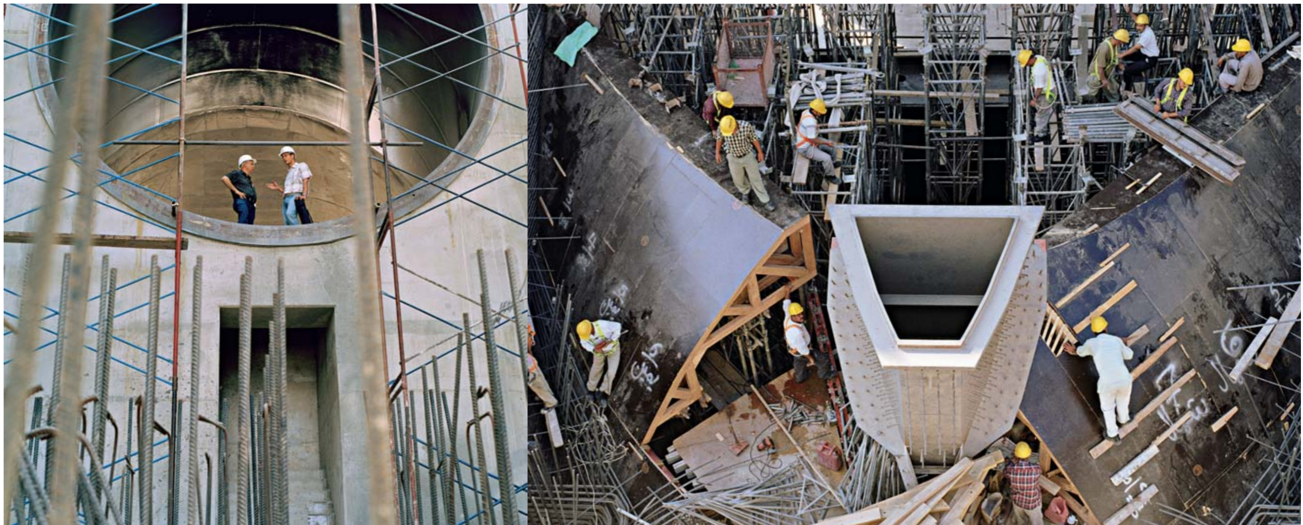
DIE BAUSTELLE IST EIN ENTLEGENER ORT. DER ZEMENT KOMMT AUS SUEZ, DER SAND AUS LUXOR UND DER STAHL AUS ALEXANDRIA.
