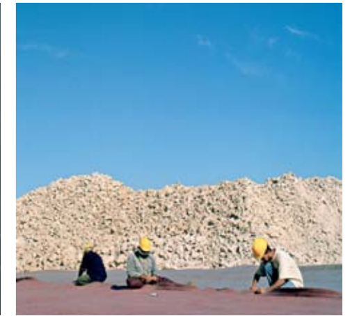
ARBEITER NÄHEN EIN SYNTHETISCHES VLIES ZUM SCHUTZ DES KANALBETTS.
