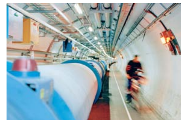
ZWISCHEN DEM GENFER SEE UND DEM JURA BOHRT SICH EIN 27 KILOMETER LANGER TUNNEL DURCH SCHWEIZER UND FRANZÖSISCHEN BODEN. ER BEHERBERGT DEN STÄRKSTEN TEILCHENBESCHLEUNIGER DER WELT.
