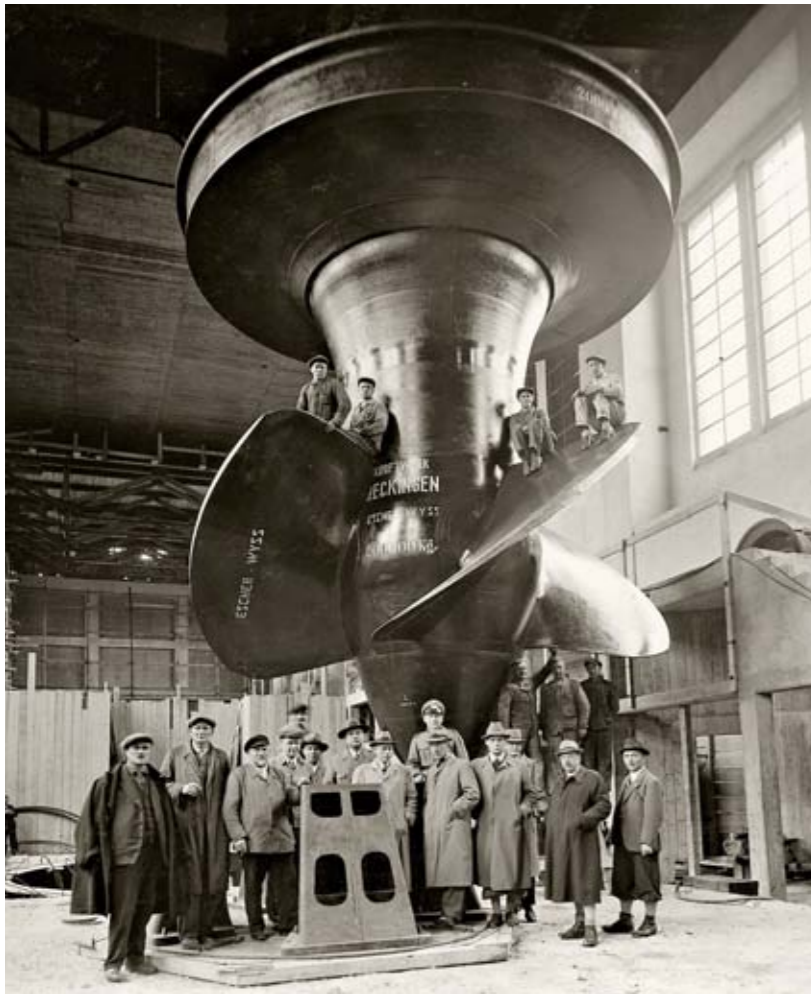
KRAFTWERK RECKINGEN, EINBAU DER KAPLAN-TURBINE, 1941.
