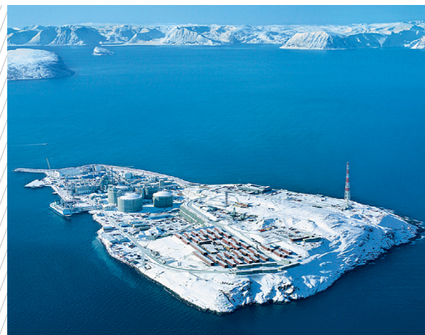
DIE ERSTE GASVERFLÜSSIGUNGSANLAGE EUROPAS ENTSTEHT IN NORWEGEN.
