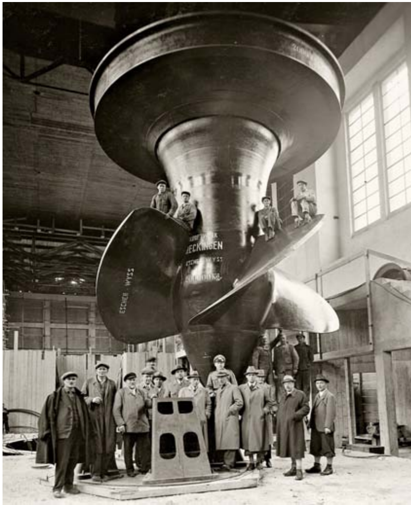
KRAFTWERK RECKINGEN, EINBAU DER KAPLAN-TURBINE, 1941.
