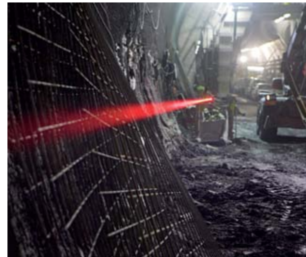
MIT HILFE DES LASERSTRAHLS BLEIBEN DIE TUNNELBAUER EXAKT AUF DEM RICHTIGEN KURS.
