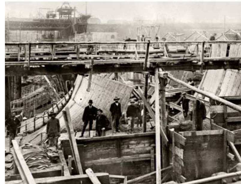
KRAFTWERK LAUFFENBURG, SCHALUNG DER TURBINENSAUGSCHLÄUCHE, 1910.
